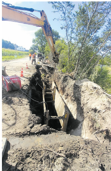
Postępy prac kanalizacyjnych
