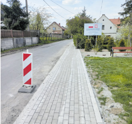
Remont drogi w Zachowicach
