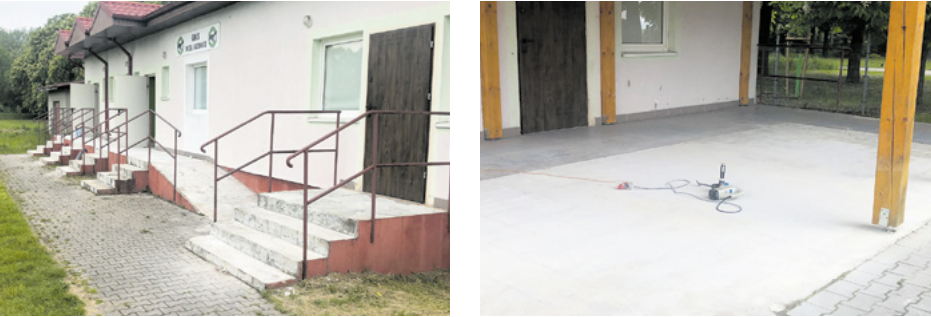
Remont świetlicy w Sadowicach
