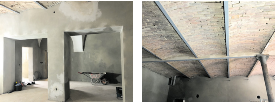
Remont świetlicy w Zabrodziu
