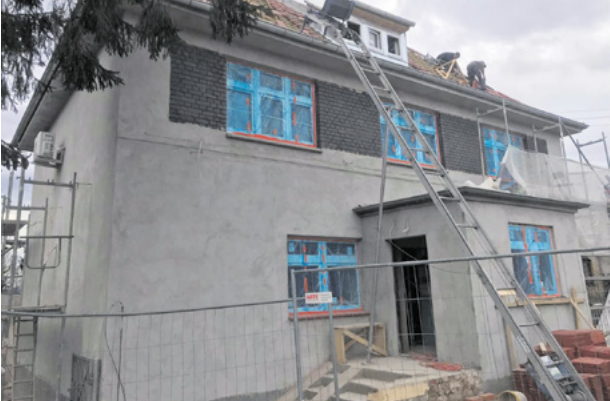
Postępy prac remontowych przychodni w Gniechowicach
