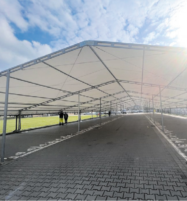
Nowe pokrycie dachu hali targowej
