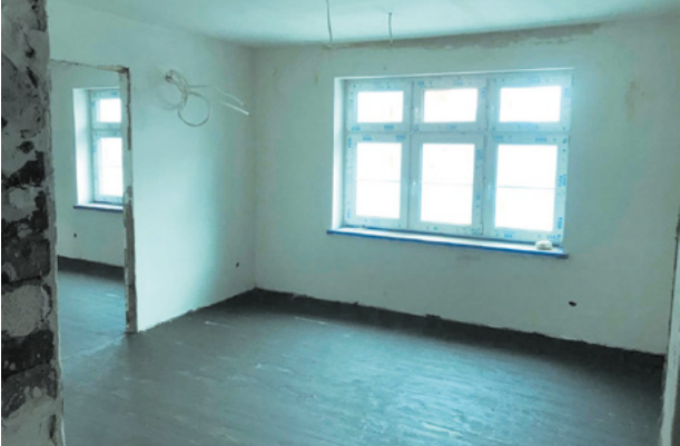
Remont przychodni w Gniechowicach
