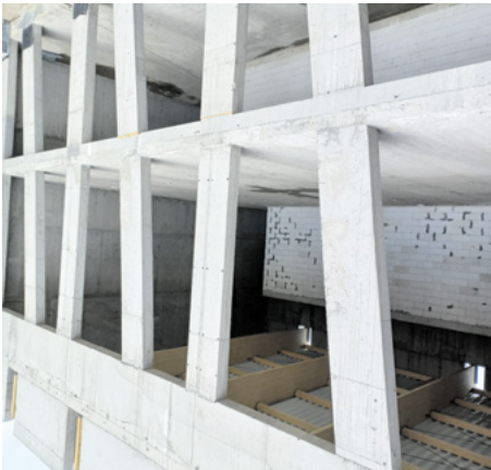
Widok z auli na fasadę wejściową na piętrze
