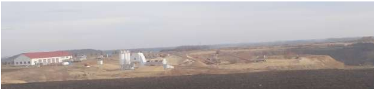
Widok istniejącej kopalni złoża kruszywa naturalnego Siedlakowice. (fot. G. Kosturek)
