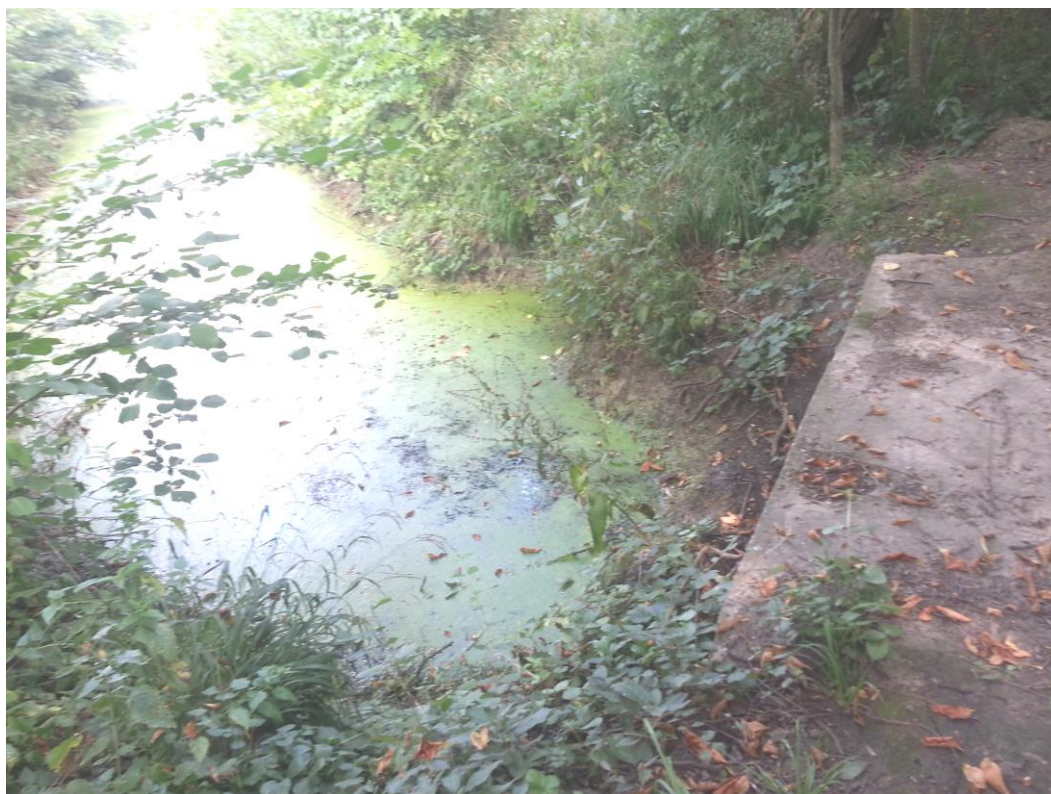
Zdjęcie nr 9 – Istniejący przepust żelbetonowy na kanale
