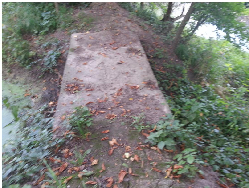
Zdjęcie nr 10 – Istniejący przepust żelbetonowy na kanale
