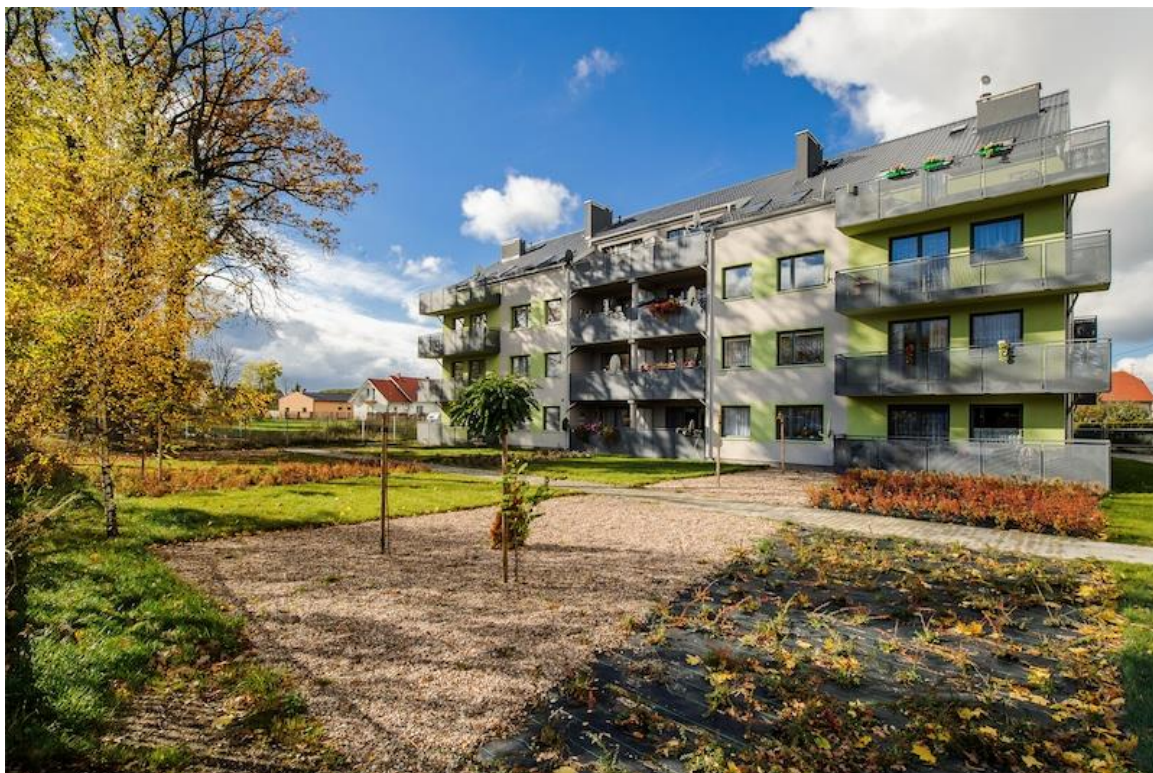
Budynek komunalny w Kątach Wrocławskich
