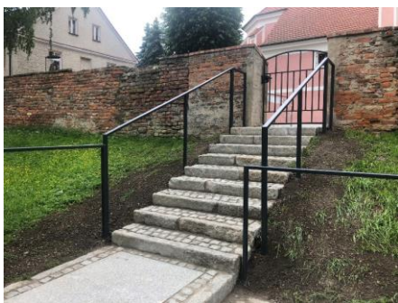
Fot. Wykonane schody wraz z furtką do przejścia przez mur przykościelny
