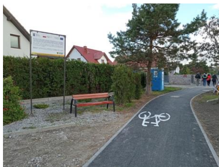
Fot. Droga rowerowa przez Mokronos Górny: w trakcie robót oraz po wykonaniu prac
