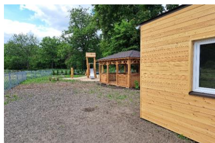
Fot. Budowa terenu rekreacyjnego w Rybnicy
