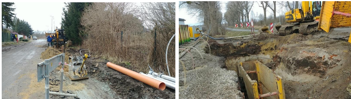
Fot. Budowa kanalizacji sanitarnej w Mokronosie Górnym – inwestycja w trakcie realizacji
