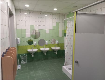
Fot. Wnętrze jednej z dwóch sal dydaktycznych oraz przynależnego do sali sanitariatu, w rozbudowanej części przedszkola
