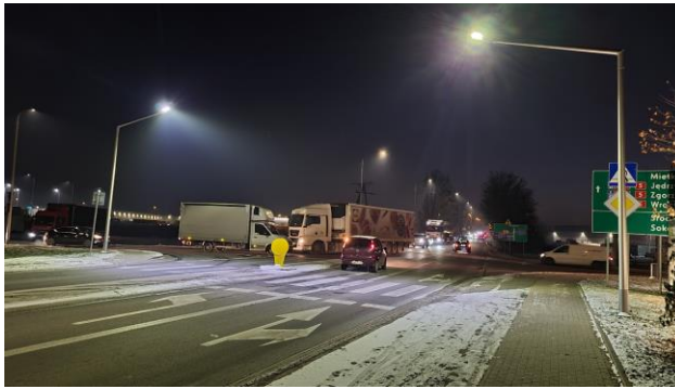
Fot. Kąty Wrocławskie doświetlenie przejścia dla pieszych na ul. Popiełuszki przy skrzyżowaniu z ul. Handlową
