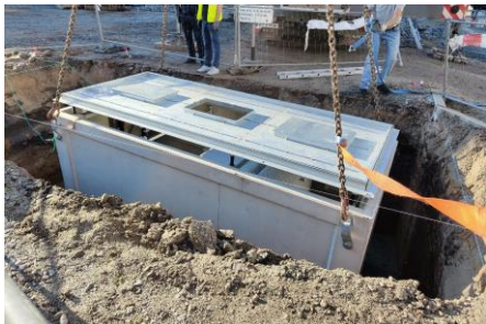
Fot. Rynek – montaż podziemnych zbiorników na selektywną zbiórkę odpadów
