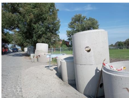
Fot. Budowa kanalizacji sanitarnej w Cesarzowicach - inwestycja w trakcie realizacji
