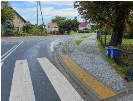
Fot. Droga powiatowa w Bogdaszowicach po wykonaniu robót
