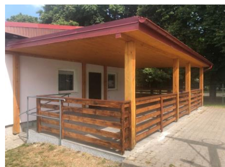
Fot. Wyremontowane schody wraz z rampą umożliwiającą dojście do poszczególnych szatni oraz nowa balustrada wraz z wyremontowaną posadzką na tarasie przy wejściu głównym do świetlicy
