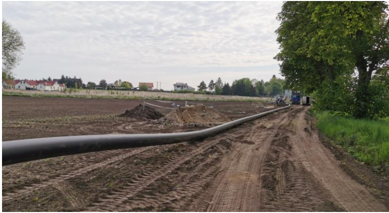
Fot. Budowa rurociągu tłoczego Sadków-Oczyszczalnia Ścieków w Jurczycach L=4775 mb.
