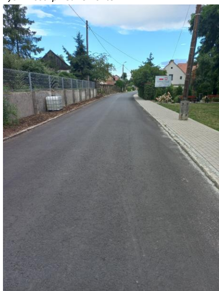
Fot. Droga w ul. Piwnej w Zachowicach po remoncie
