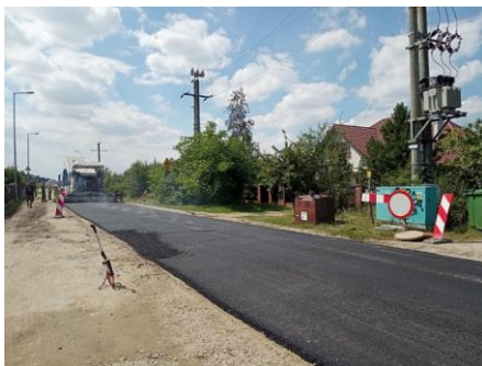
Fot. Budowa kanalizacji sanitarnej w Mokronosie Górnym - odtworzenie nawierzchni dróg po wykonanych pracach kanalizacyjnych.
