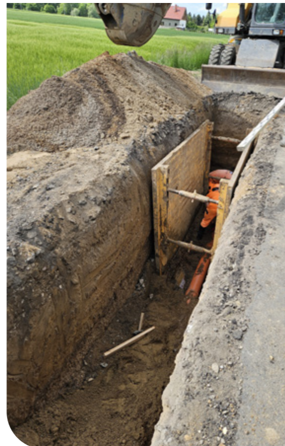
Fot. Budowa kanalizacji sanitarnej w Pełcznicy przy placu zabaw
