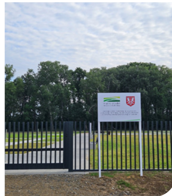
Fot. Widok na wejście wraz z tablicą o dofinansowaniu
