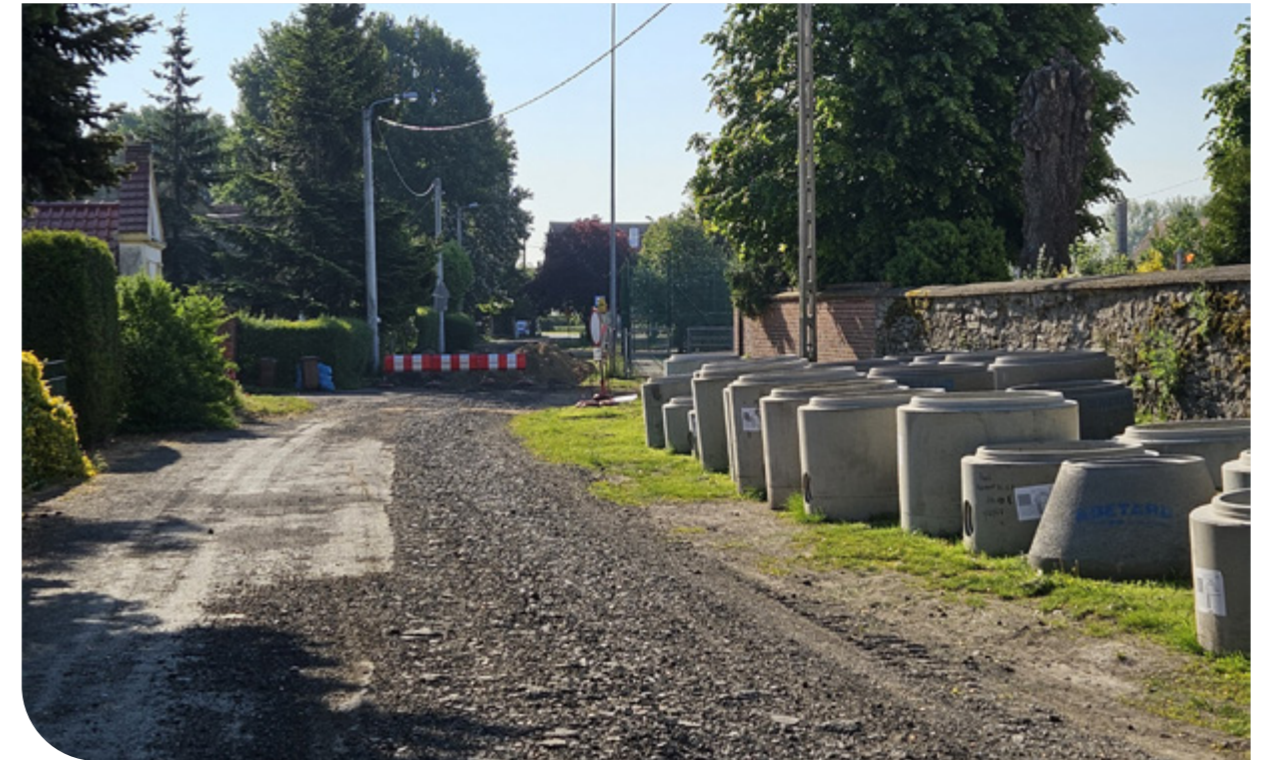
Fot. Budowa kanalizacji sanitarnej w Pełcznicy przy placu zabaw
