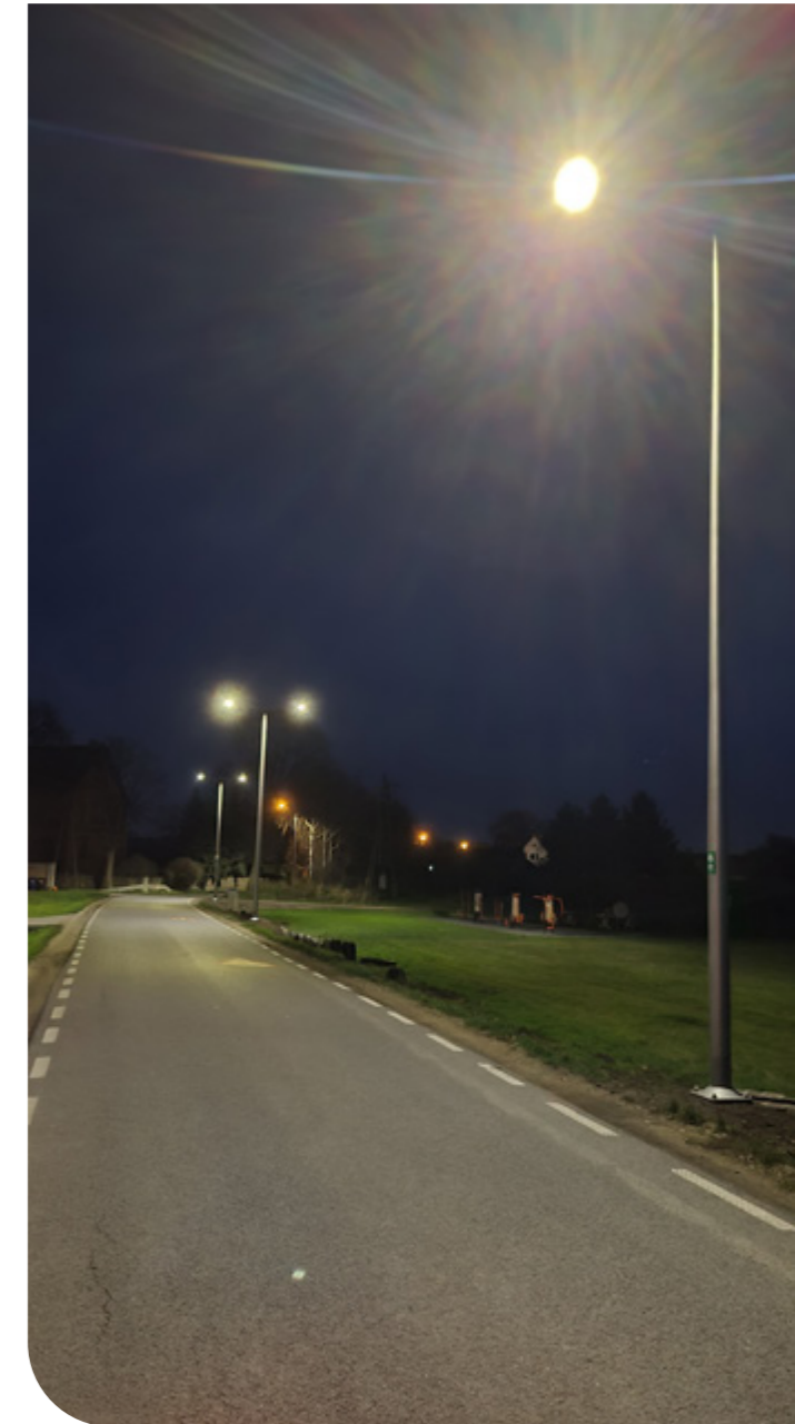
Fot. Strzeganowice wjazd od strony Sośnicy
