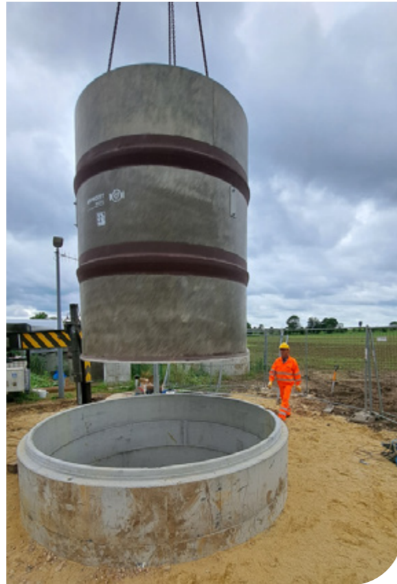
Modernizacja przepompowni ścieków PP2 w miejscowości Pietrzykowice
