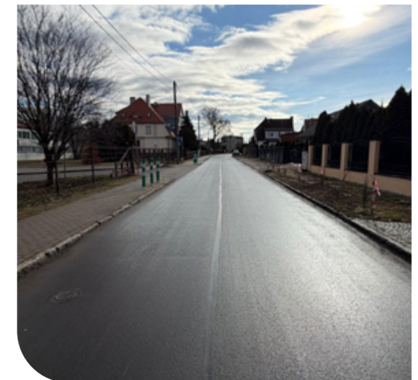
Fot: Odcinek drogi ul. Kościelnej w Smolcu
