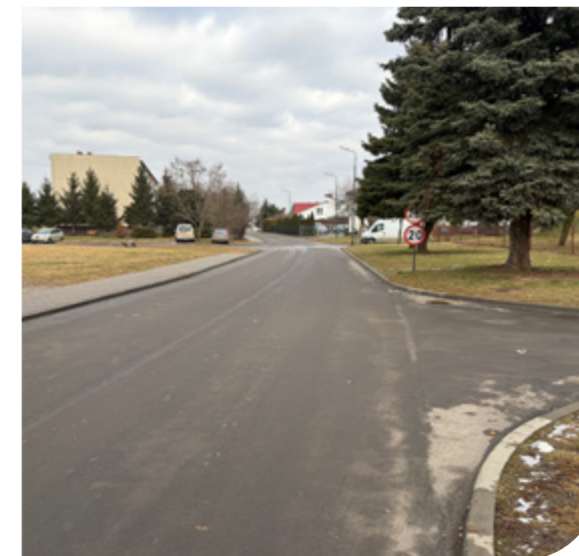
Fot: Odcinek drogi ul. Spokojnej w Gniechowicach
