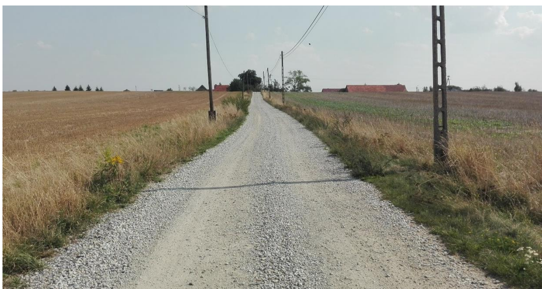
Droga po naprawie kruszywem drogowym
