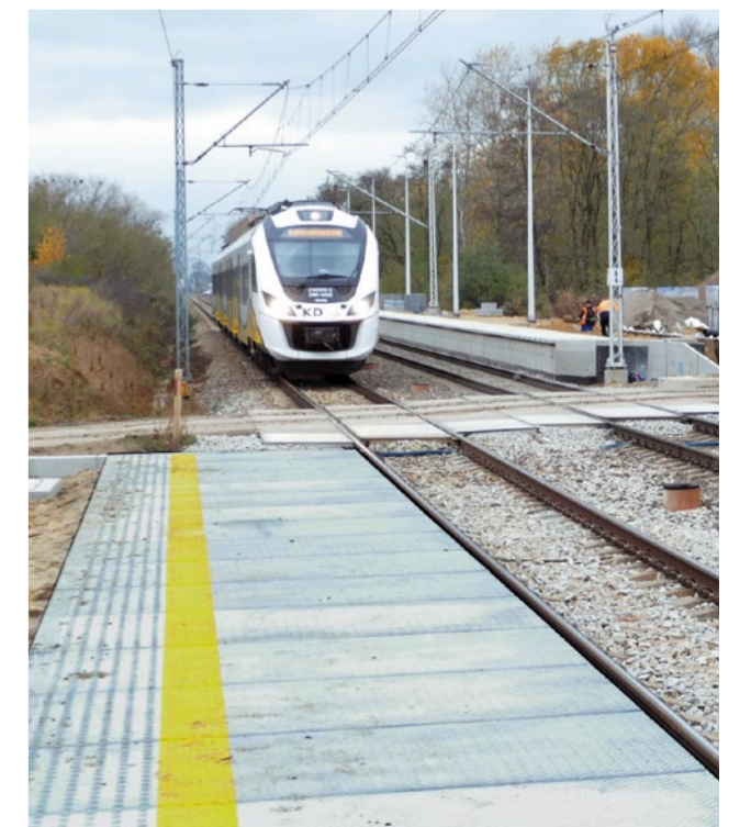
Remontowany przystanek kolejowy w Mokronosie Górnym.
