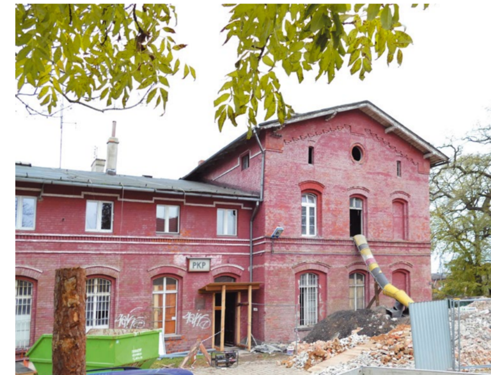
Remont dworca w Smolcu.
