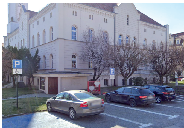
Ratusz przed przebudową
