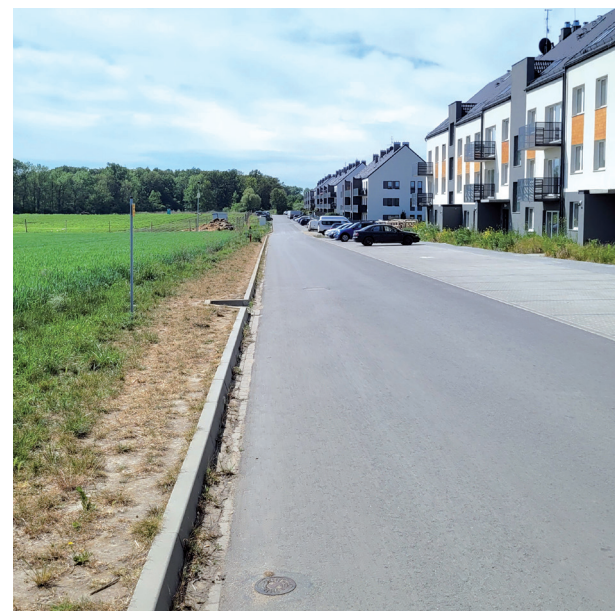
Planowane oświetlenie w Krzeptowie ul. Jagodowa
