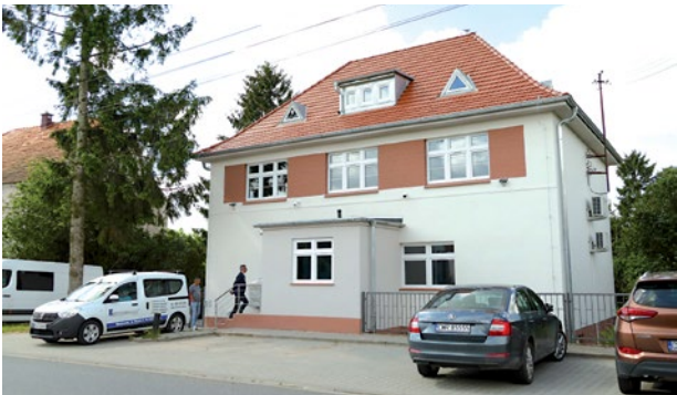
Odnowiony budynek przychodni w Gniechowicach
