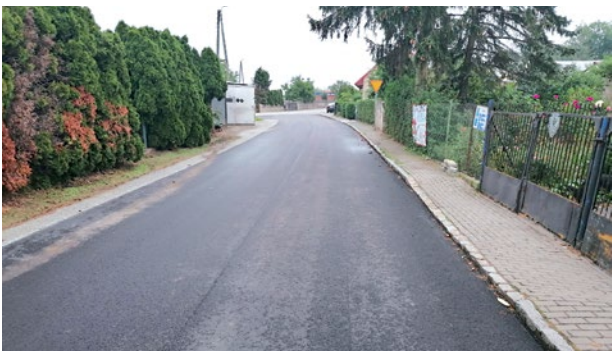
Remont ul. Lotniczej w Czerńczycach
