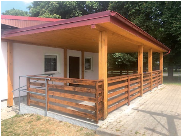
Szatnie i świetlica wiejska przy boisku w Sadowicach
