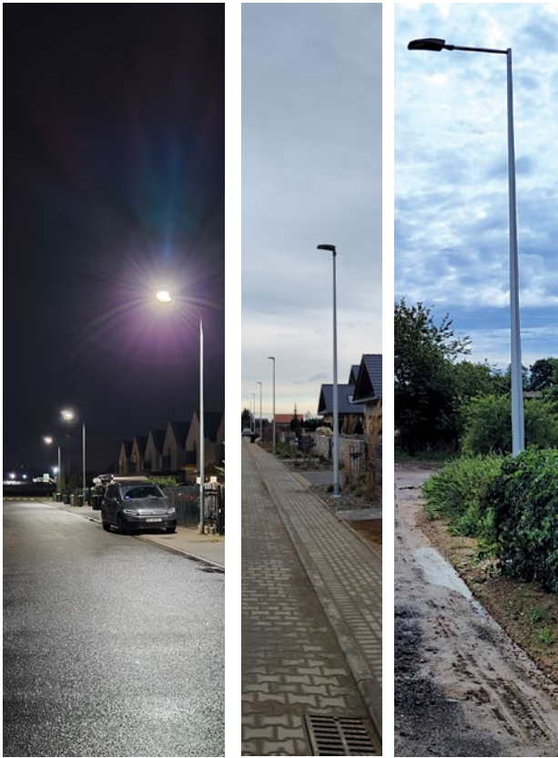
Nowe oświetlenie drogowe
